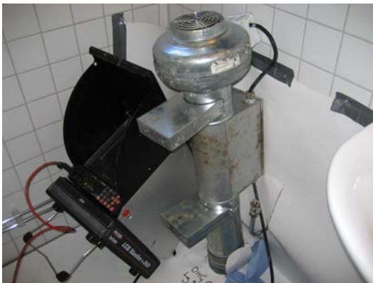
Bild B1:2 Fläkt kopplas till avloppssystemet bl a för att hindra att lukter sprider sig i bostadsutrymmena.
