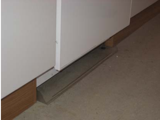
Bild 7.25 Genom att placera ett enkelt skydd under diskmaskin, kyl och frys kan läckage upptäckas tidigt.
