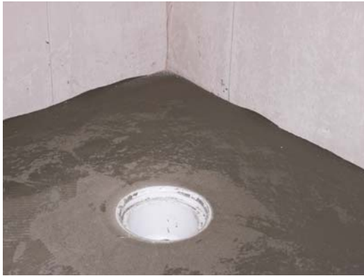
Bild 7.11 Ett golv som försetts med pågjutningar eller spackel måste tillåtas att torka så att det nya tätskiktet inte skadas av byggfukten. Kemiska emissioner från fuktskadade material kan ge upphov till inomhusmiljöproblem.
