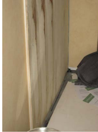
Bild 7.19 Ett annat sätt att hindra dammspridning kan vara att montera en byggskiva framför öppningar som saknar dörr. Golvet skyddas med en tjock papp.
