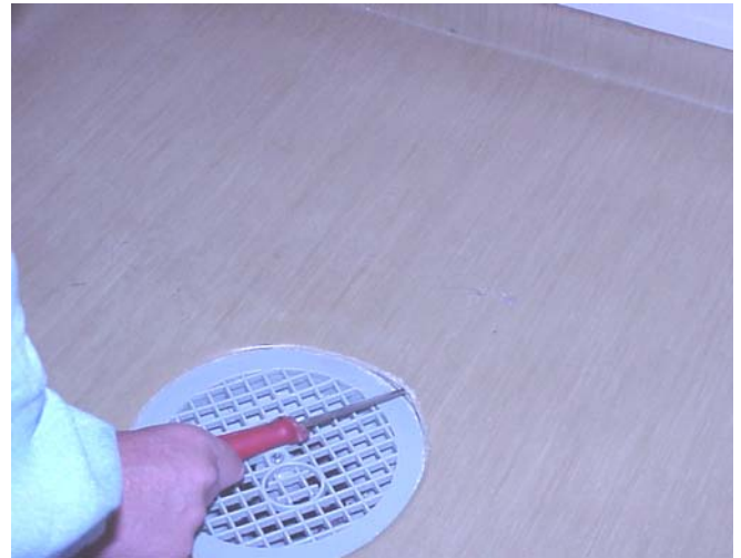
Bild 7.4 Anslutningen mellan golvbrunn och tätskikt är en viktig del att kontrollera. Mattan på bilden är inte väl ansluten mot golvbrunnen.
