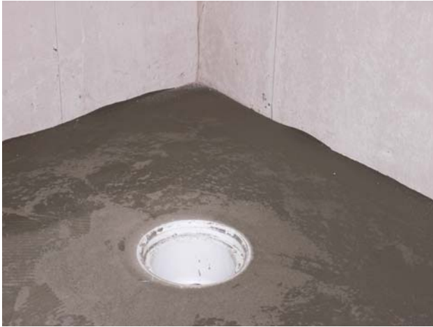
Bild 7.14 Den gamla gjutjärnsbrunnen har ersatts med en ny golvbrunn som möjliggör god tätning mellan golvbrunn och det nya tätskiktet samt är lätt att rengöra.
