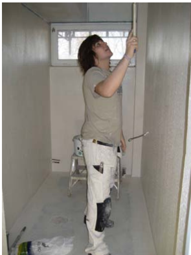
Bild 7.12 Väggen förses med en primer före det vätskebaserade tätskiktet rollas på.
