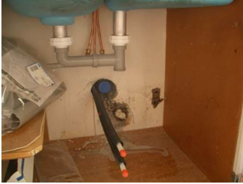
Bild 7.20 Ett korrekt monterat rör-i-rör-system innebär att eventuellt utläckandevatten kommer att föras till ett utrymme där vattenutströmningen snabbt upptäcks. Utrymmet bör även vara försett med avlopp, dvs vara placerat i våtutrymmen med golvbrunn.
