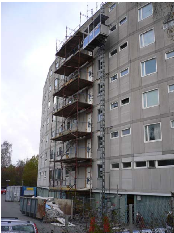
Bild 7.1 Genom en bygghiss kan rivningsmaterial och nya material transporteras från och till varje våningsplan med en mindre störning än om byggnadens egen hiss skulle användas för transporter.
