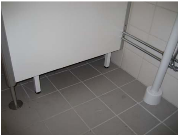
Bild 7.28 I skärmväggen mellan handfat och tvättmaskin har fukttåliga material valts så att mögelpåväxt inte skall uppstå om materialet utsätts för vatten.
