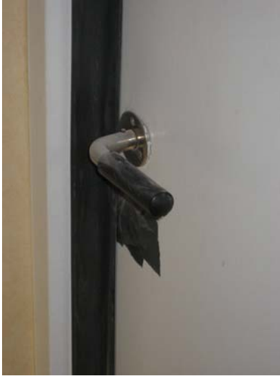
Bild 7.18 Ett enkelt sätt att hindra spridning av damm inom en lägenhet är att tätta dörröppningar. Avskärmning av arbetsområdet sker många gånger med plastfolier som ansluts lufttätt mot golv/vägg/tak.
