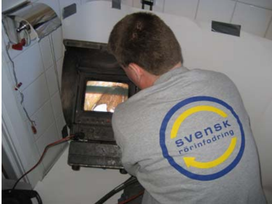
Bild B1:1 Arbetet med rörinfodringen följs med hjälp av kamera som är monterad vid munstycket som sprutar ut materialet för infodringen.
