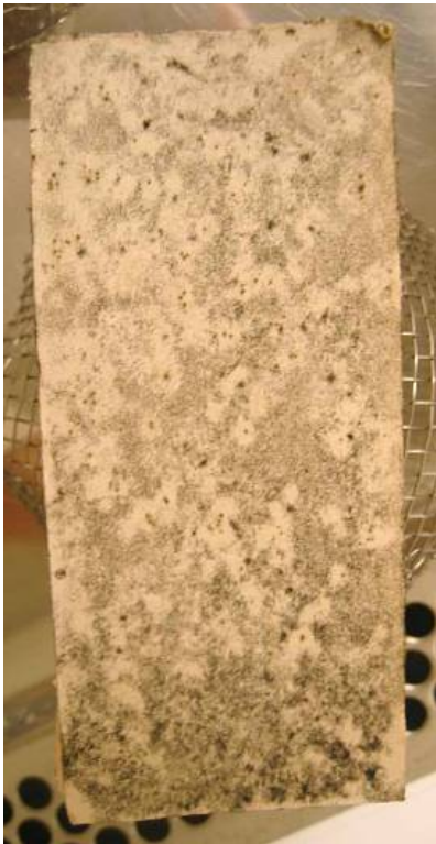
Bild 7.2 Gipsskivor med pappbeklädnad kan få synlig påväxt av mögel då den utsätts för hög fuktighet i konstruktioner. Mögelpåväxt syns inte alltid för blotta ögat som bilden visar och många gånger måste mikroskop användas för att se om materialet är mögelangripet.
