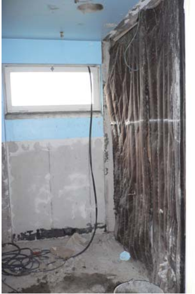
Bild 7.29 Ytterväggens uppbyggnad behöver bedömas liksom risken för inträngande vatten vid fönsteranslutningar.
