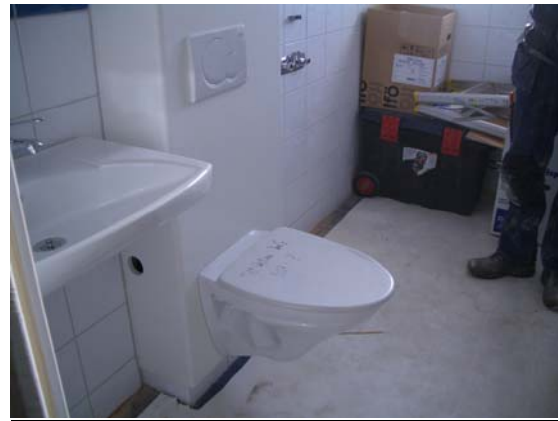
Bild 7.22 Toalettstolen monteras på kassetten som rymmer både rördragningar och vattenbehållare för toaletten.
