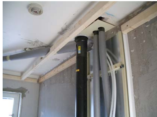
Bild 7.17 Nya horisontella rördragningar som förläggs i demonterbart undertak i våtutrymme. Vertikala stammar förläggs i en kassettlösning .
