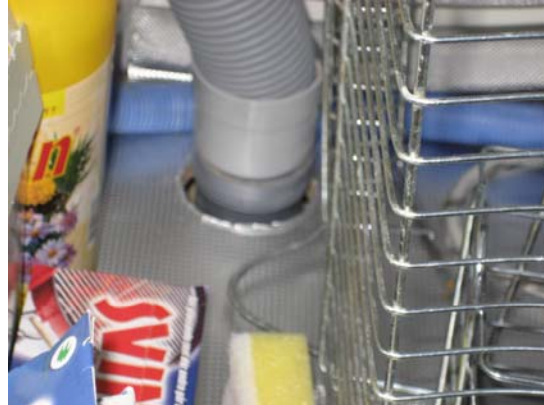
Bild 7.26 Det är viktigt att tätningen av rör sker på ett sätt så att eventuellt utläckande vatten inte förs ner i konstruktionen. Utläckande vatten skall föras fram så att det snabbt blir synligt.
