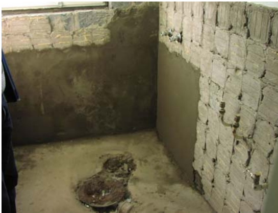
Bild 7.7 De gamla ytskikten har tagits bort för att ersättas med nytt tätskikt och ny keramisk beklädnad.
