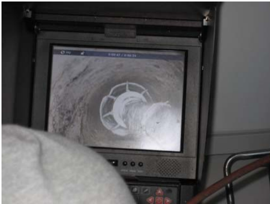
Bild 7.23 Infodringen sprutas i det gamla ren-gjorda röret med ett munstycke som är anpassad till rörets dimension. Arbetet följs med en videokamera.
