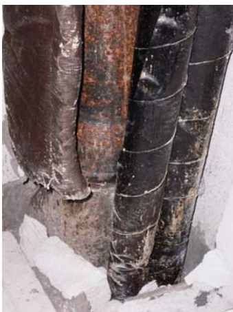
Bild 7.15 De vertikala stammarna är ofta samlade i schakt där håltagning många gånger måste göras för att kunna inventera statusen hos rör och rörisolering.
