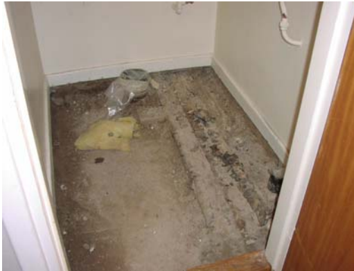
Bild 7.9 Golvet friläggs ner till ren betongyta. Golvlister av trä är inte lämpligt material att ha i utrymme där vatten kan strömma ut eller stänka.
